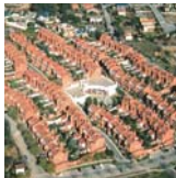
Cooperativa Can Carreras Sant Boi de Llobregat
